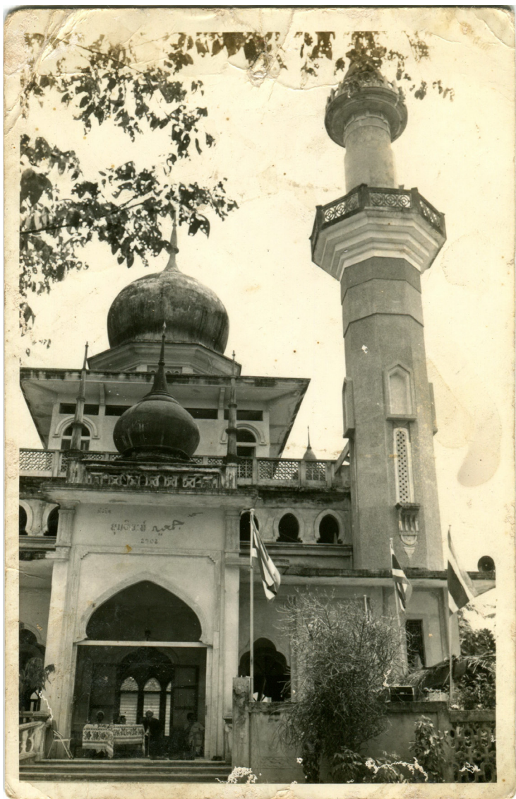
ภาพอาคารมัสยิดมุฮัมมิยะห์หลังใหม่ สร้างในปี พ.ศ. 2502
